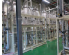
초순수 실증플랜트(2,400m 3 /d) 이온제거 및 고도화 공정(이온교환수지) 유기물 제거(자외선 산화장치) 용존산소 제거공정(탈기막)
