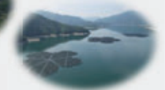
소양강 댐 수상태양광
